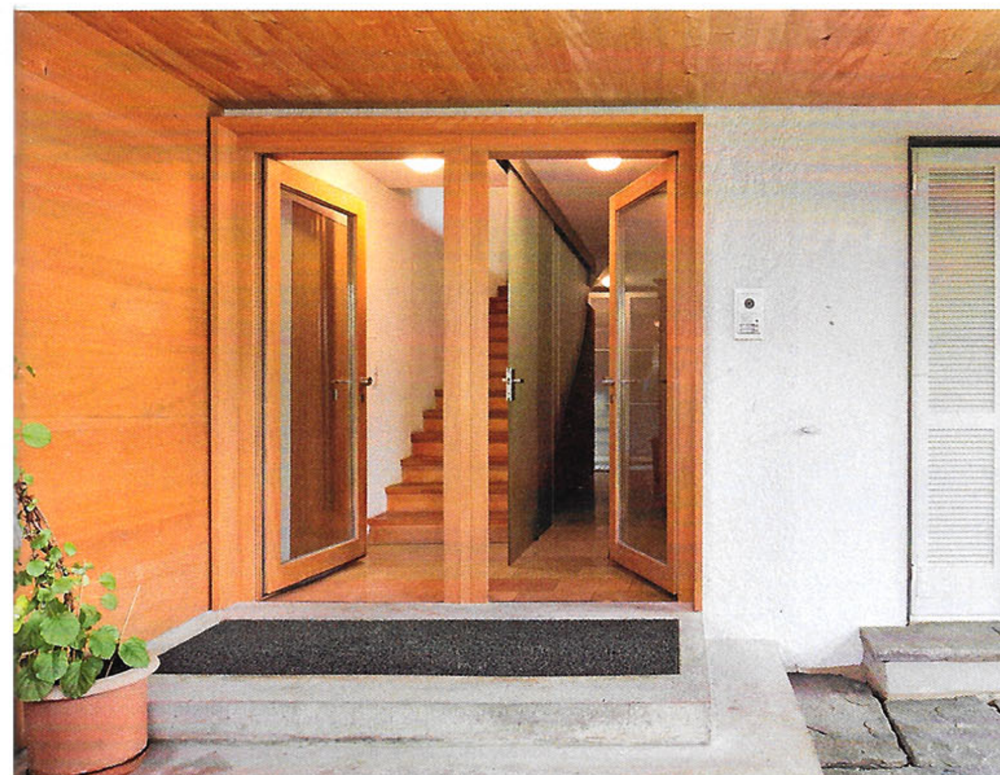
Haus Fischnaller: Beide Wohnungen erhielten einen separaten Eingang und sind durch eine Schiebetüre getrennt. Die bestehende Treppe wurde eingewandelt.
